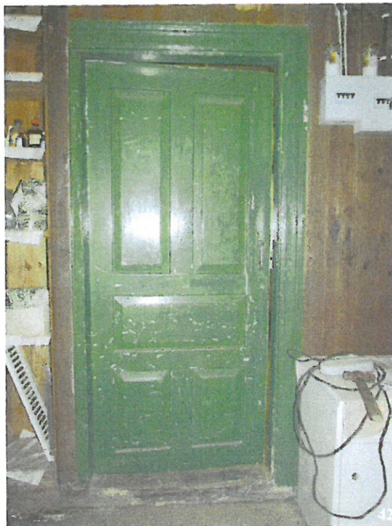
40) Tõenäoliselt omavalmistatud ukselink elamu välisukse VU1 siseküljel; 41) 1920. aastatest pärinev tahveluks U1; 42) 1920. aastatest pärinev tahveluks U2 – käepide on 20. saj. 1. poole vabrikutoode. 43) Sahvri lauduks U3—käepide on 20. sajandi 1. poole vabrikutoode. Fotod: Mart Siilivask, 14.05.2015.
