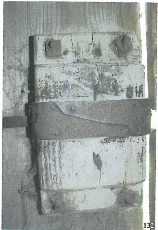
130) Lauda (reg-nr 21018) värava VU1 sisekülg; 131) Algupärane puitlukk lauda väraval; 132) Lauda värava VU1 puitlukk metallpõõnaga. Fotod: Mart Siilivask, 14.05.2015.
