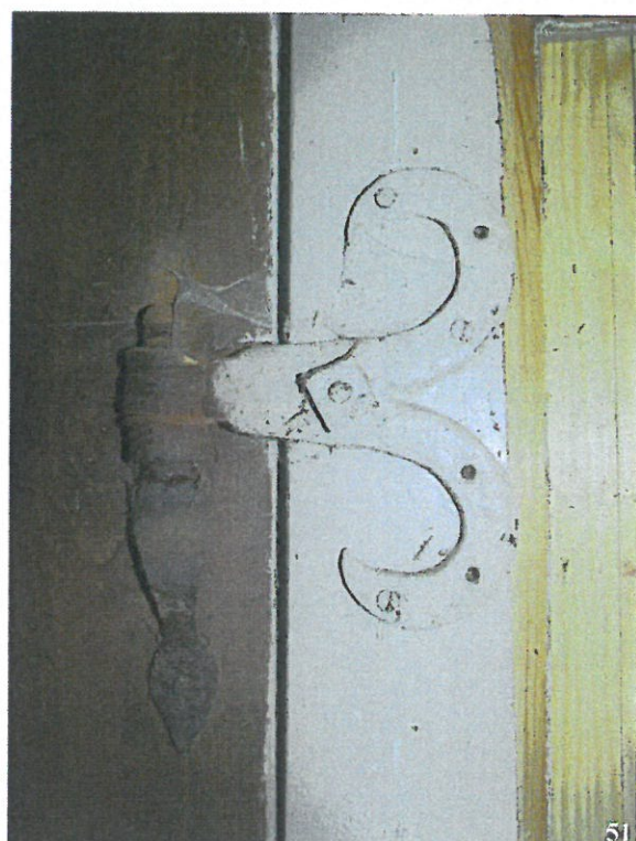
48) Ukse U3 sisekülg sahvri poolt; 49) Siseuks U4 ja piirdeliist kambri poolt; 50-51) Lõhutud tahvlitega ja osalt hilisema laudisega kaetud siseuks U5 ja selle algupärane sepishing. Fotod: Mart Siilivask, 14.05.2015.
