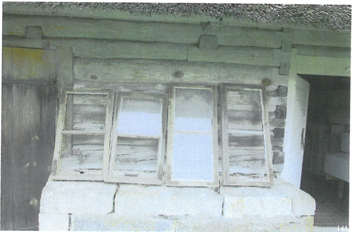
141) Vaade laudahoone esiküljele ja katuseräästale põhjast; 142) Sepisrõngas (ohelikuots?) laudahoone põhjaseinal; 143) Rehielamu algsed aknaraamid, mis olid hoiul laudahoone laoruumis. Fotod: Mart Siilivask, 14.05.2015.
