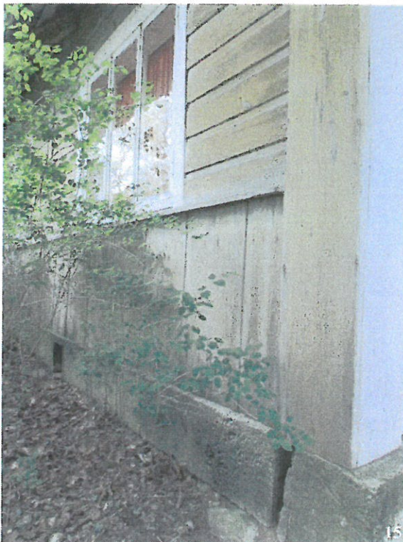
13) Elamu kambritetiiva põhjapoolne otsakül, vaade edelast; 14) Kambritetiiva otsakülje algupärane voodrilaudis ja tahitud kiviblokkidest vundament; 15) Voodrilaudis hoone idaküljel; 16) Kambritetiiva edelanurk algupärase kattelauga ja katuseräästas. Fotod: Mart Siilivask, 14.05.2015
