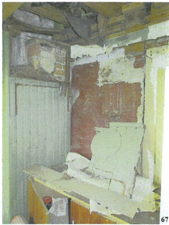
64) Ahi (AHI2) ja pliit soemüüriga ruumis 11; 65) Vabariigi aegne ahjuuks, tehasetähis: "J. Aivaz ja Ko, Tallinn"; 66) Soemüür ja lavats väikeses kambris (ruum 8). 67) Korstna K1 korstnjalga ümbritsev saviga täidetud laudvooderdis (vasakul) ja reheahju tagaseina õlivärviga üle värvitud paekivimüür (paremal). Fotod: Mart Siilivask, 14.05.2015.
