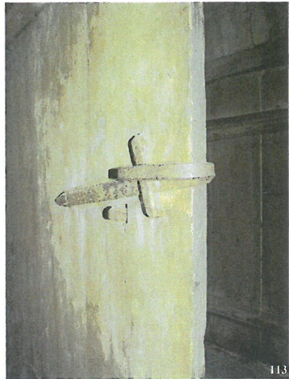
110) Sepikoja korsten ja kaminaks kohandatud kolle; 111) Ukse VU1 sisekülj; 112) Sepikoja vaheuks U1 sepsilingiga. 113) Sepikoja ukse U1 link tagaküljelt. Fotod: Mart Siilivask, 14.05.2015
