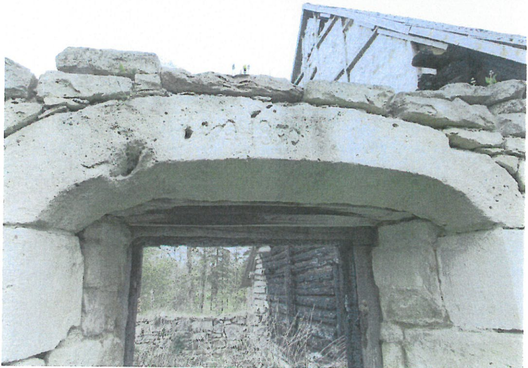
11) Vaade rehealuse väravale ja müürile välisukse VU6 raidkivisilluse ja ukseavaga; 12) Rehealuse ukse VU6 dolomiidist ukse sillus kannab aastaarvu "1890". Fotod: Mart Siilivask, 14.05.2015.
