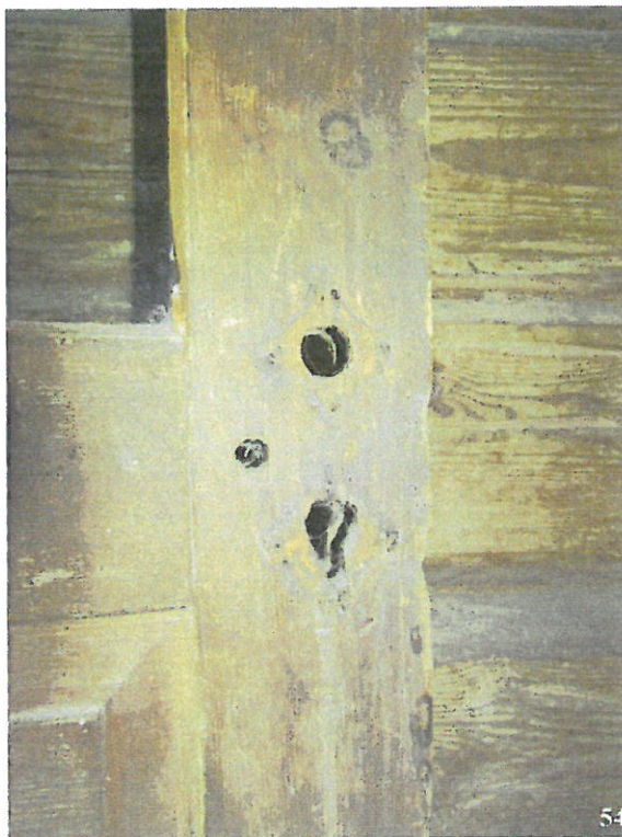
52) Eeskoja klaasidega tahveluks U6; 53/55) Sepishinged ukse U6 siseküljel; 54) Algupärase ukse lingi avad ja jäljendid ukse U6 välisküljel Fotod: Mart Siilivask, 14.05.2015.
