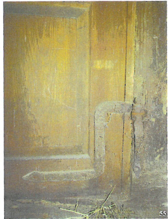
52) Eeskoja klaasidega tahveluks U6; 53/55) Sepishinged ukse U6 siseküljel; 54) Algupärase ukse lingi avad ja jäljendid ukse U6 välisküljel Fotod: Mart Siilivask, 14.05.2015.
