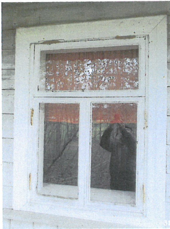
29-30) Aken A12 ja vana sepishinge konks sama akna lengil—leng on algupärane, akna- raamid ja piirdeliistud pärinevad arv 20. sajandi teisest poolest; 31) Aken A11, aknal 20. sajandi esimese poole tehasehinged; 32) Kinnitushaagid akna A6 siseküljel. Fotod: Mart Siilivask, 14.05.2015
