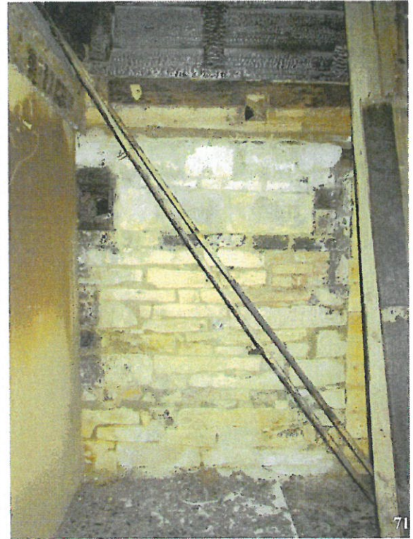
68) Reheahi (AHI 1) rehetoa; 69) Rehetoa palklaji ja seinad väheste tulekahustustega; 70) Rehetoa lae edelanurk peatalaga. 71) Reheahju tagakülg Magamistoa (Ruum 7) poolt ja tulekahju tagajärjel söestunud palksein selle kohal. Fotod: Mart Siilivask, 14.05.2015.
