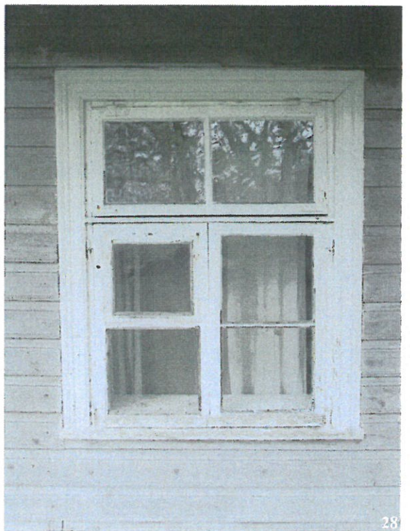
25-28) Algupärased aknad A5, A6, A7 ja A8 hoone idaküljel. Akendel on säilinud algupärased profileeritud piirdelauad. Seinä voodrilaudis pärineb 20. sajandi teisest poolest. Fotod: Mart Siilivask, 14.05.2015
