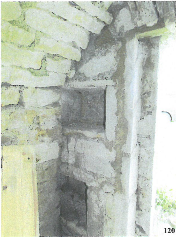
118) Keldri (reg nr 20117) esimese ruumi võlvlagi ja vaheukse sillus; 119) Keldri (reg nr 20117) tagumise ruumi silindervölv; 120) Paekivist nišid keldriruumi esiseinas uksest VU3 paremal; 121) Paekivist nišš keldriruumi esiseinas uksest VU3 vasakul. Fotod: Mart Siilivask, 14.05.2015.
