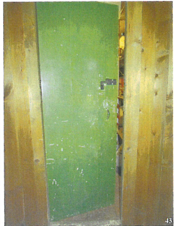
40) Tõenäoliselt omavalmistatud ukselink elamu välisukse VU1 siseküljel; 41) 1920. aastatest pärinev tahveluks U1; 42) 1920. aastatest pärinev tahveluks U2 – käepide on 20. saj. 1. poole vabrikutoode. 43) Sahvri lauduks U3—käepide on 20. sajandi 1. poole vabrikutoode. Fotod: Mart Siilivask, 14.05.2015.
