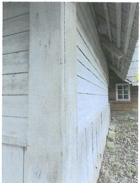
13) Elamu kambritetiiva põhjapoolne otsakül, vaade edelast; 14) Kambritetiiva otsakülje algupärane voodrilaudis ja tahitud kiviblokkidest vundament; 15) Voodrilaudis hoone idaküljel; 16) Kambritetiiva edelanurk algupärase kattelauga ja katuseräästas. Fotod: Mart Siilivask, 14.05.2015
