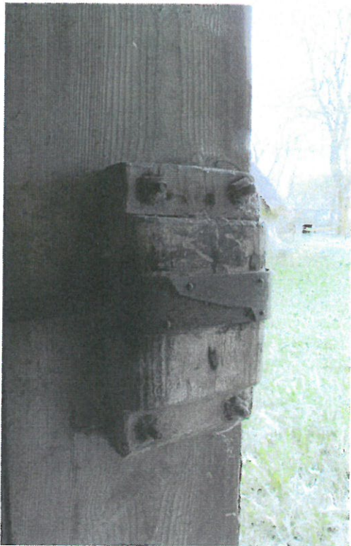
130) Lauda (reg-nr 21018) värava VU1 sisekülg; 131) Algupärane puitlukk lauda väraval; 132) Lauda värava VU1 puitlukk metallpõõnaga. Fotod: Mart Siilivask, 14.05.2015.
