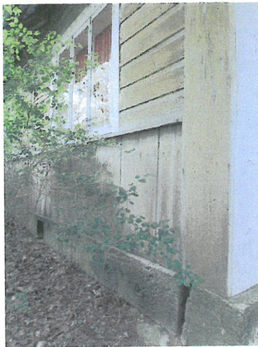
33) Lubjakivist (nn Saaremaa dolomiidist) soklikvaadrid ja tuulutusaava hoone põhjaküljel; 34-35) Lubjakivist soklikvaadrid ja voodrilaudis elamu põhjatiiva ida- ja põhjaküljel. Fotod: Mart Siilivask, 14.05.2015.
