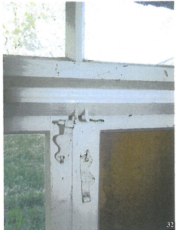
29-30) Aken A12 ja vana sepishinge konks sama akna lengil—leng on algupärane, akna- raamid ja piirdeliistud pärinevad arv 20. sajandi teisest poolest; 31) Aken A11, aknal 20. sajandi esimese poole tehasehinged; 32) Kinnitushaagid akna A6 siseküljel. Fotod: Mart Siilivask, 14.05.2015
